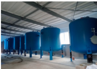
Modernizacja Stacji Uzdatniania Wody - w trakcie realizacji
