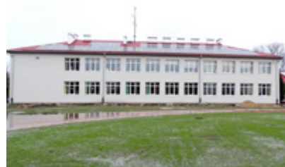
Budynek Szkoły Podstawowej
