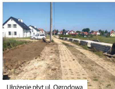
Ułożenie płyt ul. Ogrodowa
