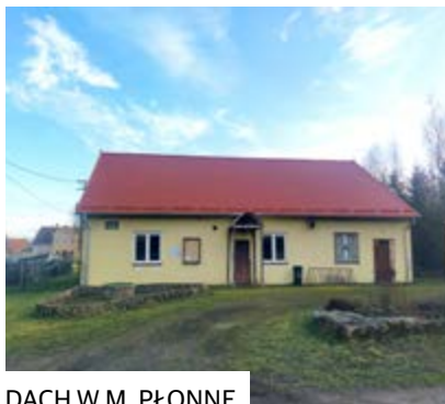
DACH W M. PŁONNE
