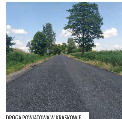
DROGA POWIATOWA W KRASKOWIE
